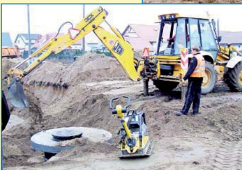
Na Ustroniu prowadzono roboty drogowe i wodno-kanalizacyjne
