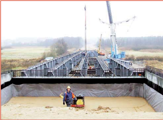
Trwa budowa mostu w trasie drogi południowo-zachodniej
